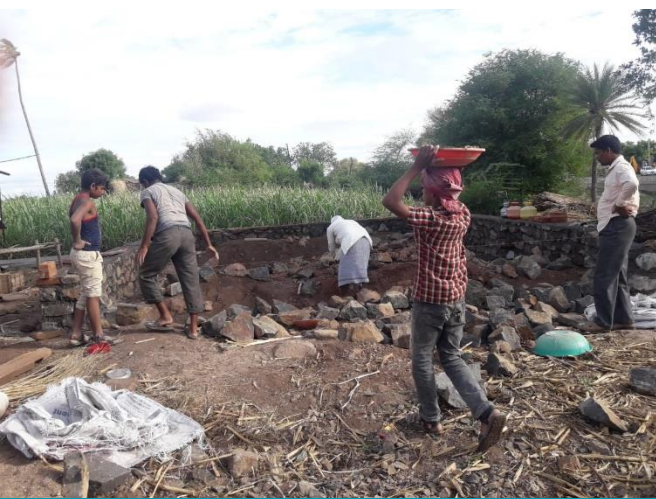
Huis in aanbouw
